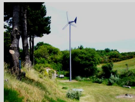
L'éolienne est installée
